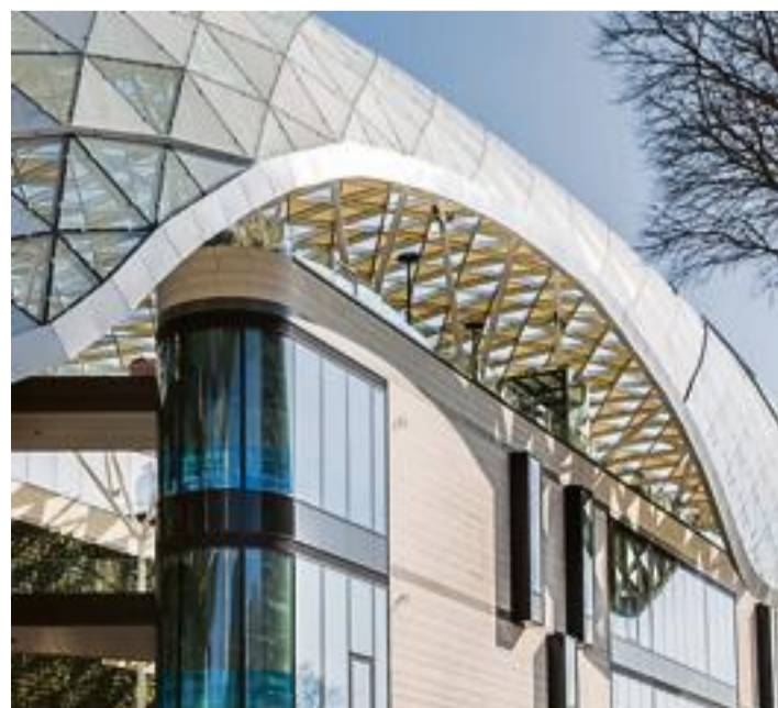
Implanté dans les quartiers sud, le centre commercial Prado, accueillera, fin mars, 50 boutiques autour des Galeries Lafayette.
